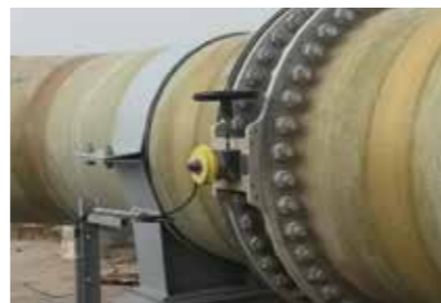
Gasventilation och skrubber
